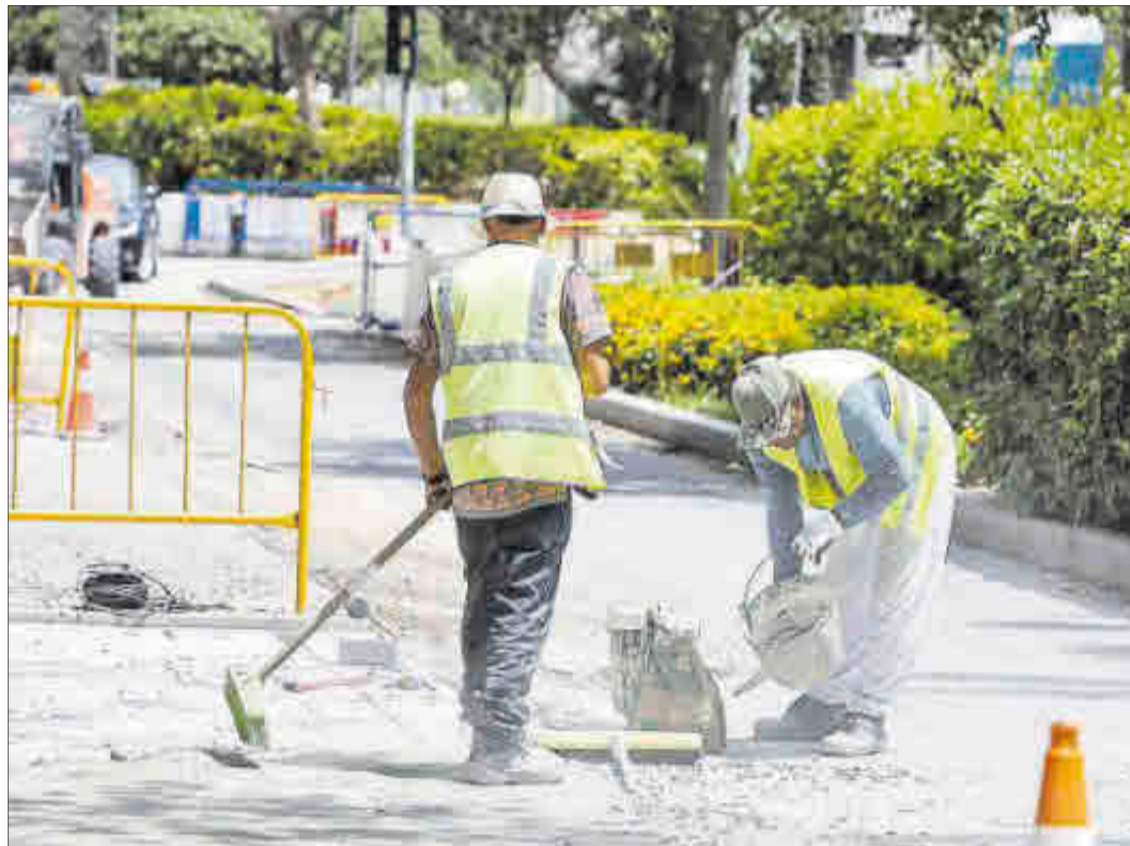
Dos trabajadores en una obra en el centro de Alicante.
